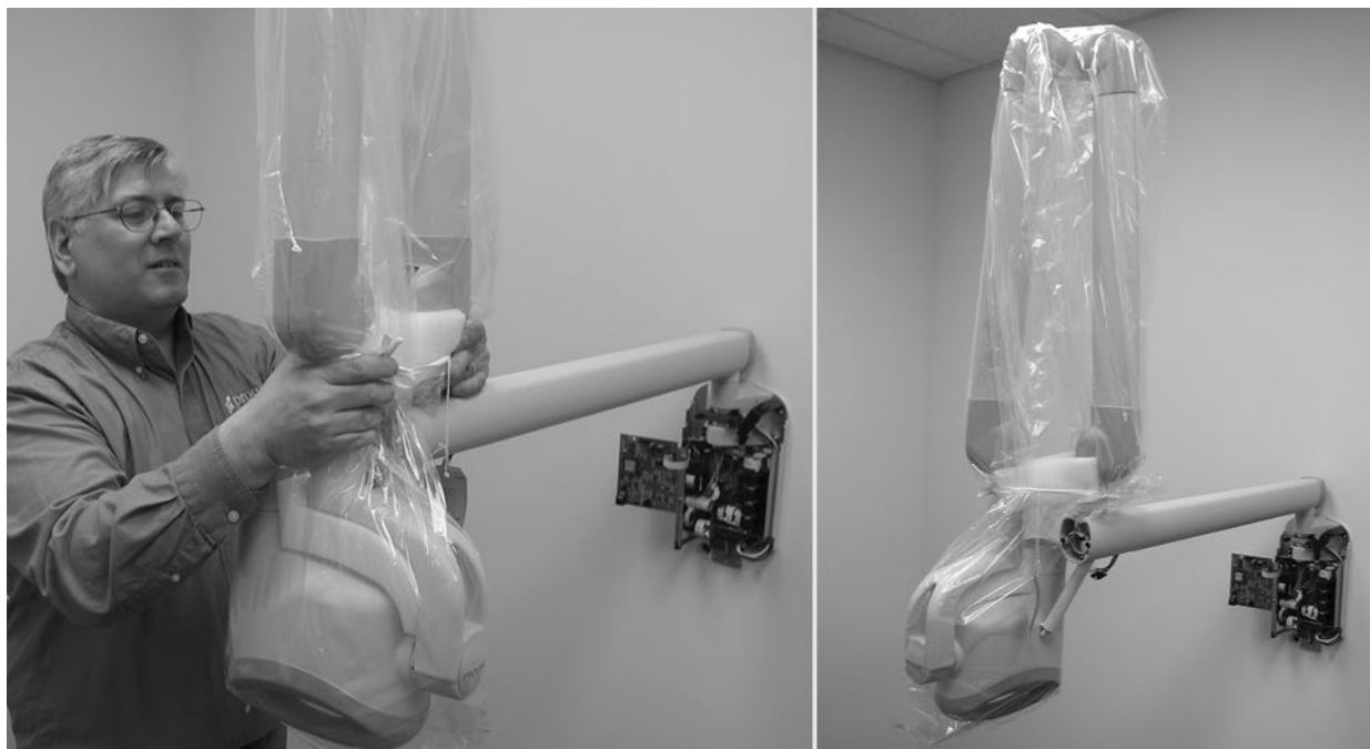
Rysunek 20 Montaż zespołu ramienia łamanego i lampy
