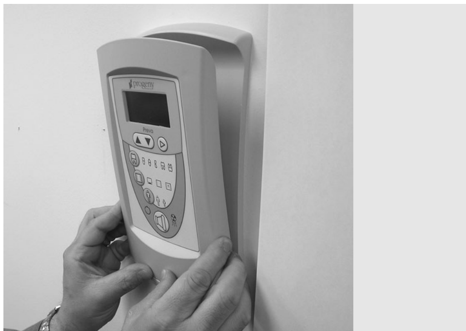
Rysunek 38 Umieszczanie panelu operatora w uchwycie
